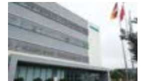
Siemens Chengdu SECW Phase 3 China
